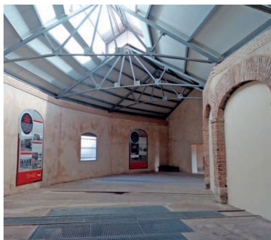
▲ Interior restaurado de los Cocherones. Utrillas.
