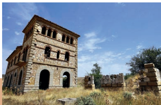
▲ Estación de Valdeconejos.
