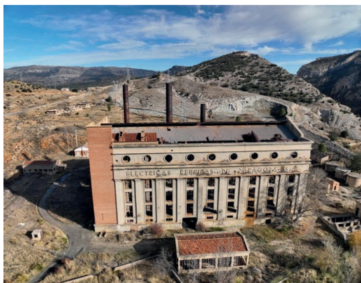
▲ Central Térmica de Aliaga.
