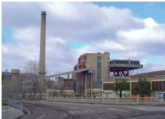
▲ Central Térmica de Escucha.
